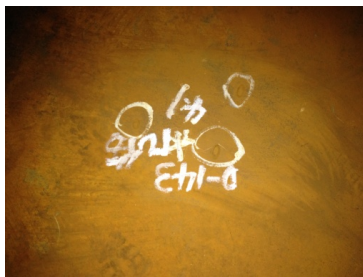
c 油罐底板的腐蚀坑
