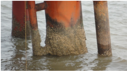
图 5 桩腿腐蚀情况 Fig.5 Corrosion of pile leg
