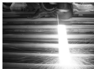
图 5 现场喷涂 Fe-Al/Cr 3 C 2 复合涂层
